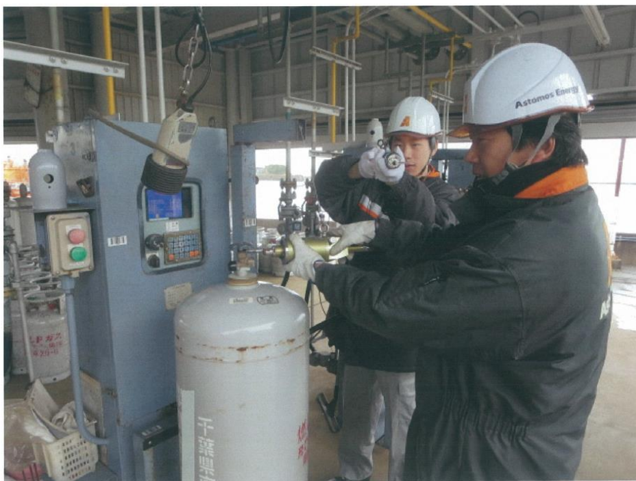
容器充填作業時のブタン濃度測定
